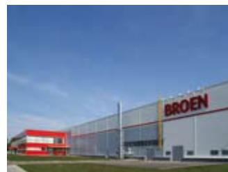
Производственный комплекс BROEN в Коломне
