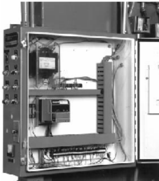
Рис. 7. Монтаж на электрической панели.
